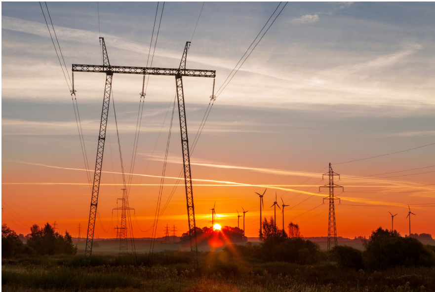
La congestión de la línea de transmisión asociada con las energías renovables relevado o eliminado mediante la aplicación de DLR.
