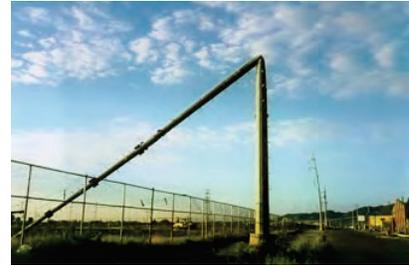
Falha no monopolo de aço de 115kV resultante de ventos fortes e detritos.
