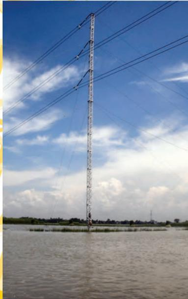
**Ângulo de funcionamento:** Conductor de pacote duplo de 400kV construído em pântano.
