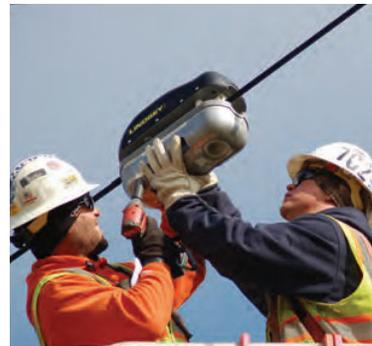
O Lindsey TLM Conductor Monitor fornece uma imagem completa do comportamento do condutor, incluindo a folga real do condutor até o solo, temperatura do condutor, corrente da linha e vibração. Ao contrário de outros monitores de linha de transmissão que usam medições auxiliares para inferir quedas, não folgas, o monitor TLM fornece medições precisas, acionáveis e de distância da folga ao solo. O monitor TLM pode ser usado em tensões do sistema de até 765kV.
