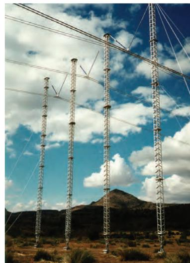
**Quatro colunas:** ERS de 400kV construído em um dia para suportar uma linha de uma usina nuclear.
