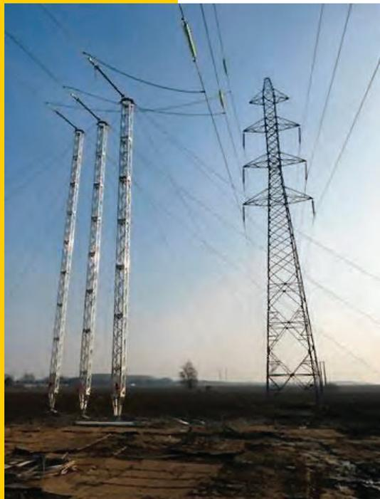
**Tensão total:** Essas estruturas de tensão total foram construídas para apoiar a linha enquanto uma torre permanente estava sendo substituída.
