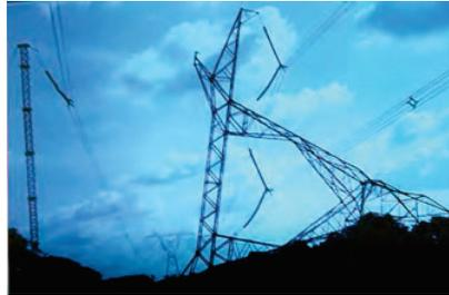
Torre de 500kV derrubada por dinamite. Lindsey ERS (extrema esquerda) usado para desvio.
