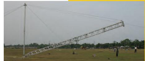
A lança de montagem 7280 pode inclinar uma coluna inteira à mão ou guincho. A metade inferior da lança também pode ser usada para elevar cargas pesadas ao topo de uma coluna do ERS.
