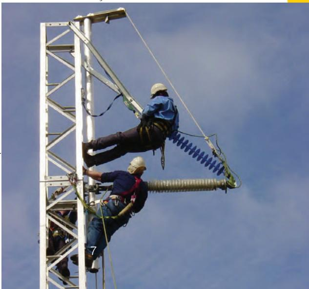
Correias de cabide (número da peça 7267, pesando 35 kg) - (mostrado à esquerda e acima do atacante superior). Eles mantêm o isolador de suspensão em um conjunto de v horizontal e fornecem um momento de restauração para o conjunto sob cargas longitudinais.
