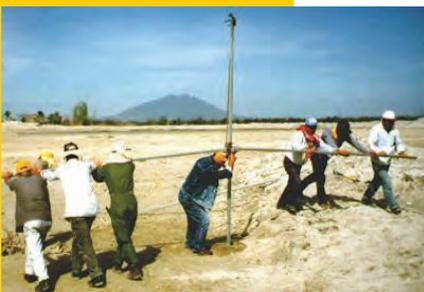
*Para condições normais ou de baixa densidade do solo, ou seja, pântano ou turfa, podem ser fornecidas âncoras de parafuso de hélice tripla de alta resistência.*
