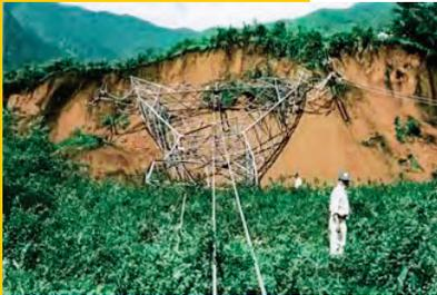
Falha na torre de 400kV devido a um furacão resultante de deslizamento de lama
