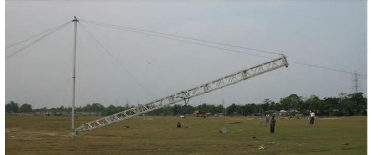
Acima, a linha do guincho e a lança de montagem: as colunas do ERS podem ser inclinadas para cima com uma linha de guincho e a lança de montagem opcional.
