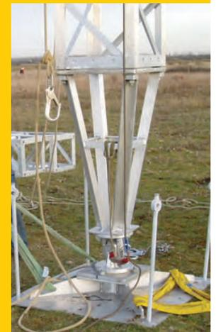
O cardan ou junta articulada (número da peça 7224, pesando 77 kg) mostrada instalada na parte superior da fundação (número da peça 7254).
