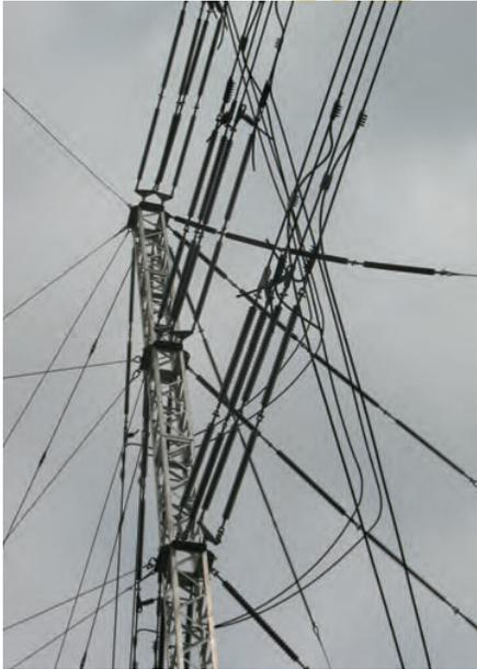
**Tensão (beco sem saída):** Ponto final de tensão total do pacote de 4 condutores de 400kV.
